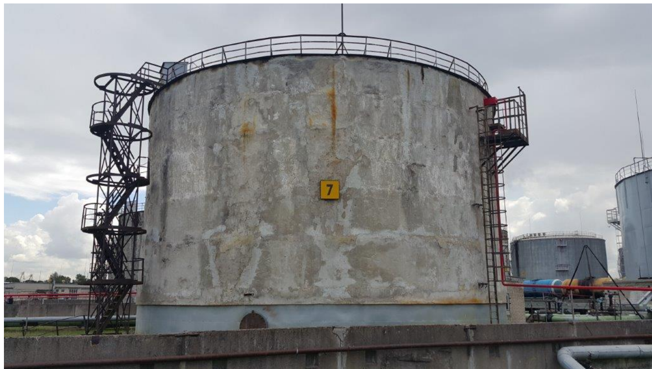
Рисунок 1 - Общий вид резервуара РВСт-3000
