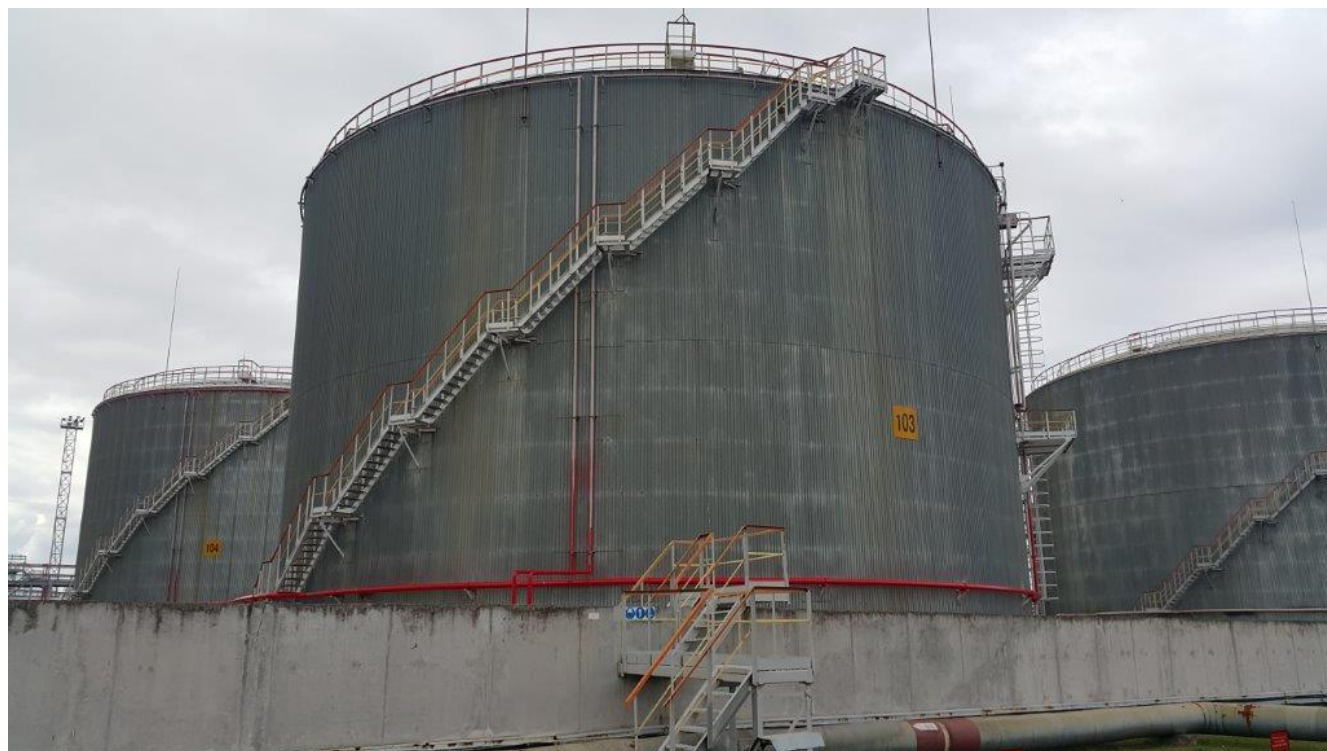
Рисунок 1 - Общий вид резервуара РВСт-10000
