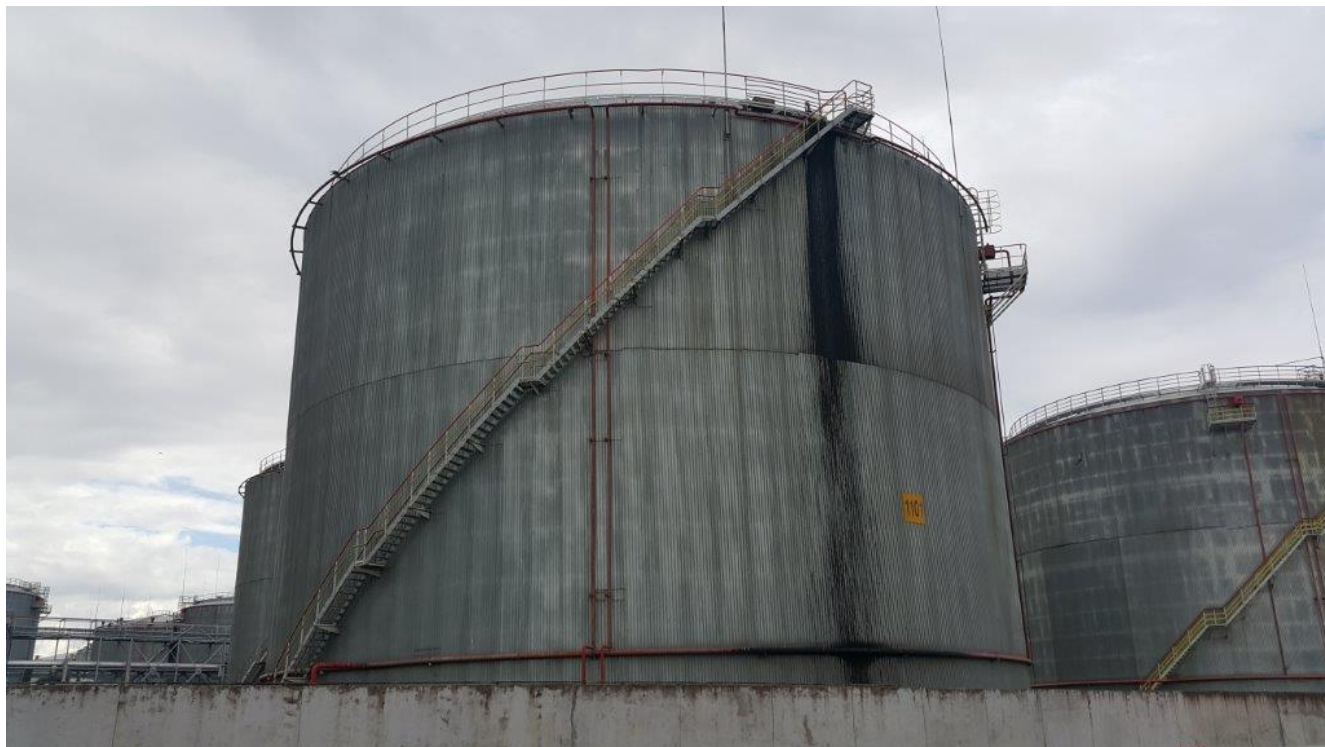
Рисунок 2 - Общий вид резервуара РВСт-15000
