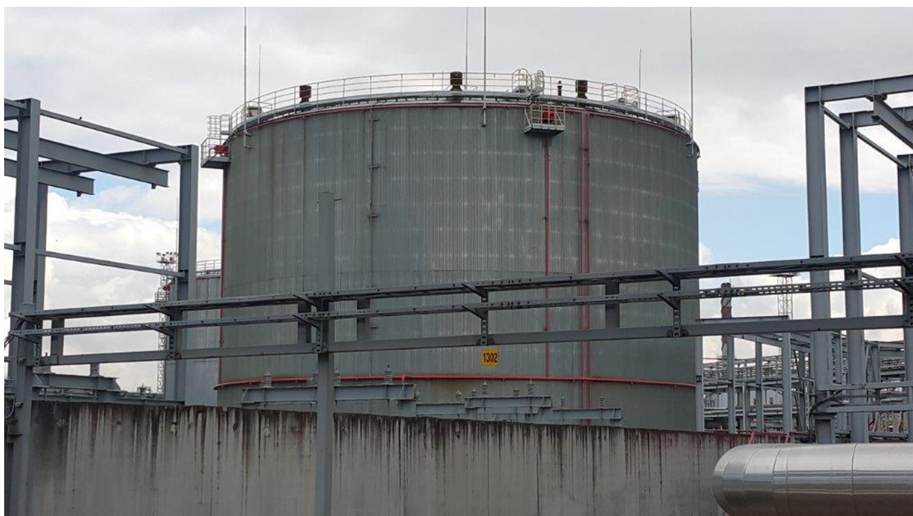
Рисунок 3 - Общий вид резервуара РВСт-20000
