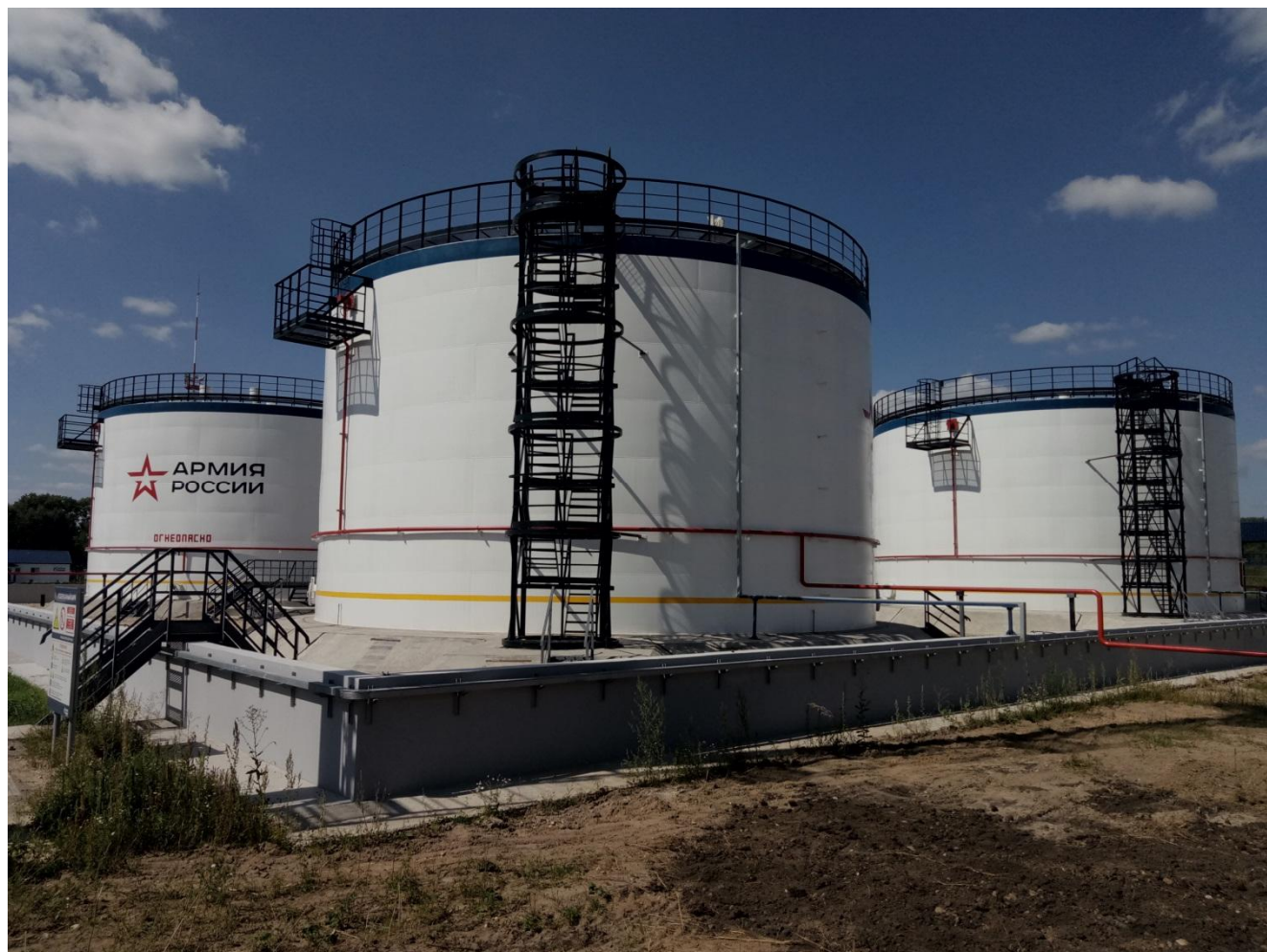
Рисунок 1 - Общий вид резервуаров РВС-2900
