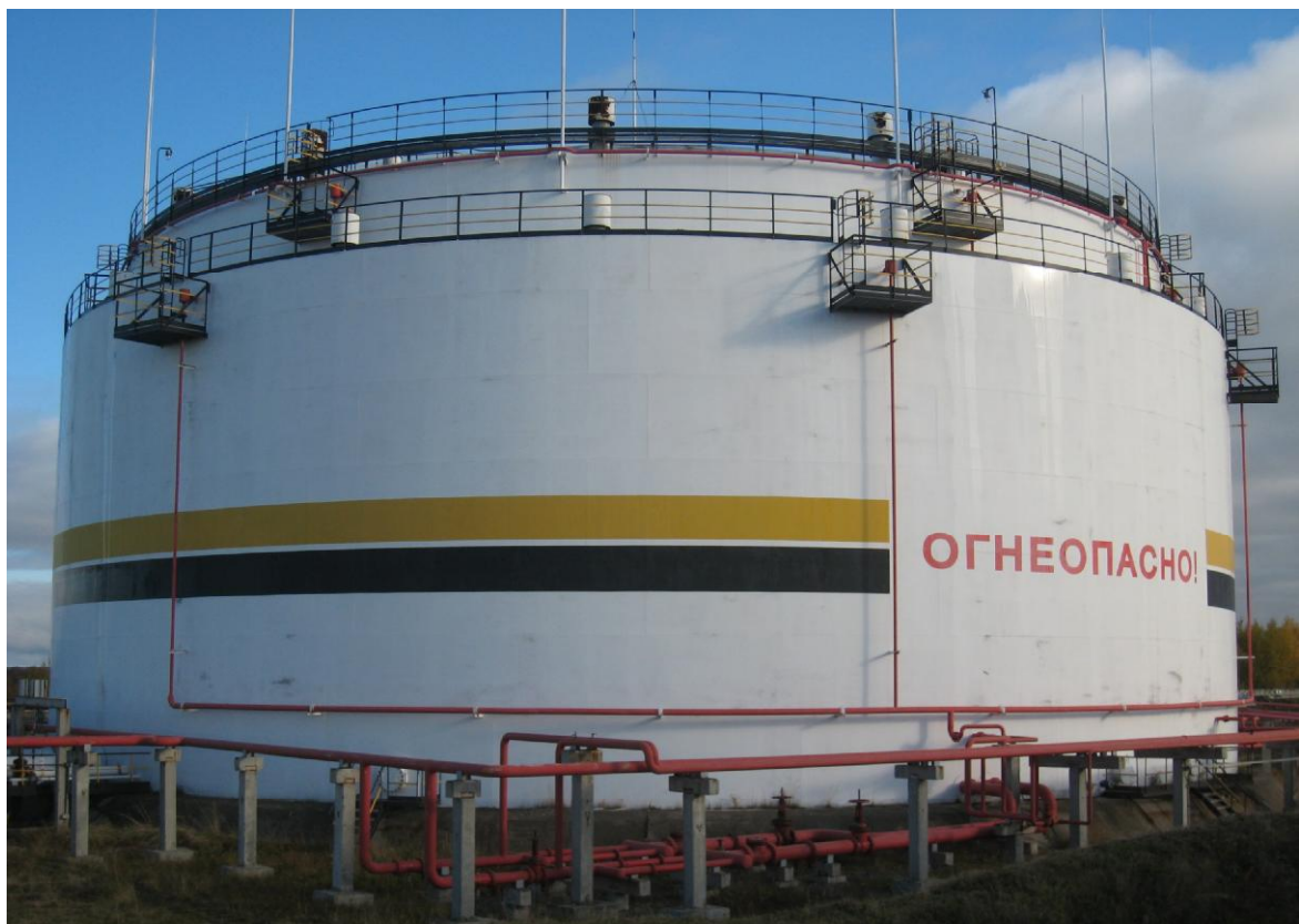
Рисунок 1 - Общий вид резервуара стального вертикального цилиндрического РВСП-20000
