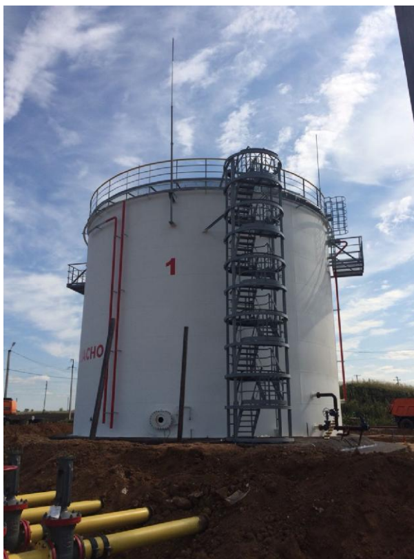
Рисунок 1 - Общий вид резервуаров стальных вертикальных цилиндрических РВС-2000
