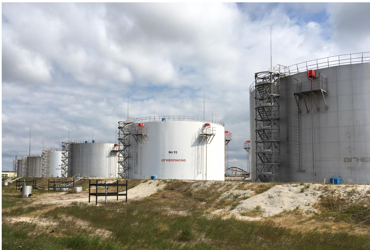
Рисунок 1 - Общий вид резервуаров РВС-5000
