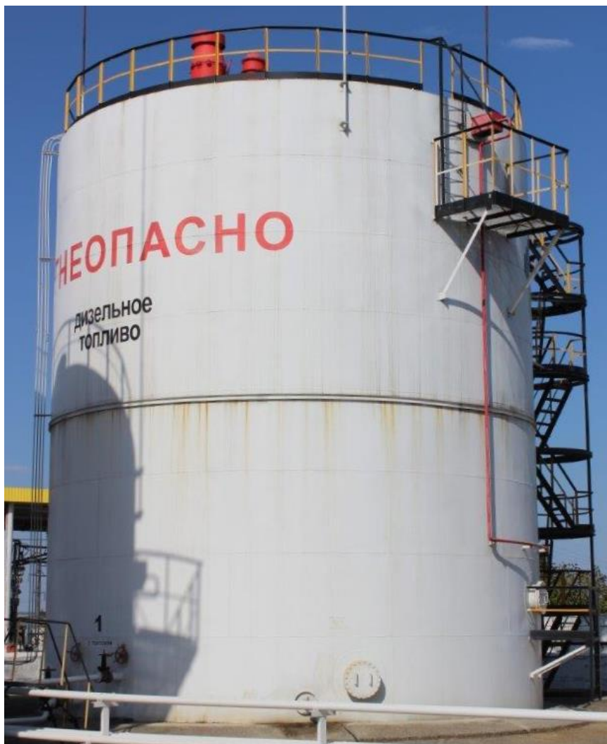
Рисунок 2 - Общий вид резервуара стального вертикального цилиндрического PVC-1000
