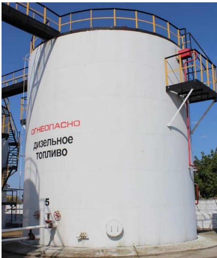
Рисунок 1 - Общий вид резервуара стального вертикального цилиндрического РВС-400
