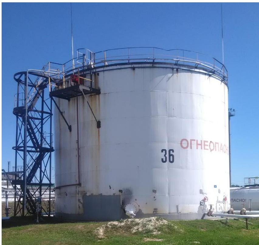
Рисунок 1 - Общий вид резервуара РВС-1000
