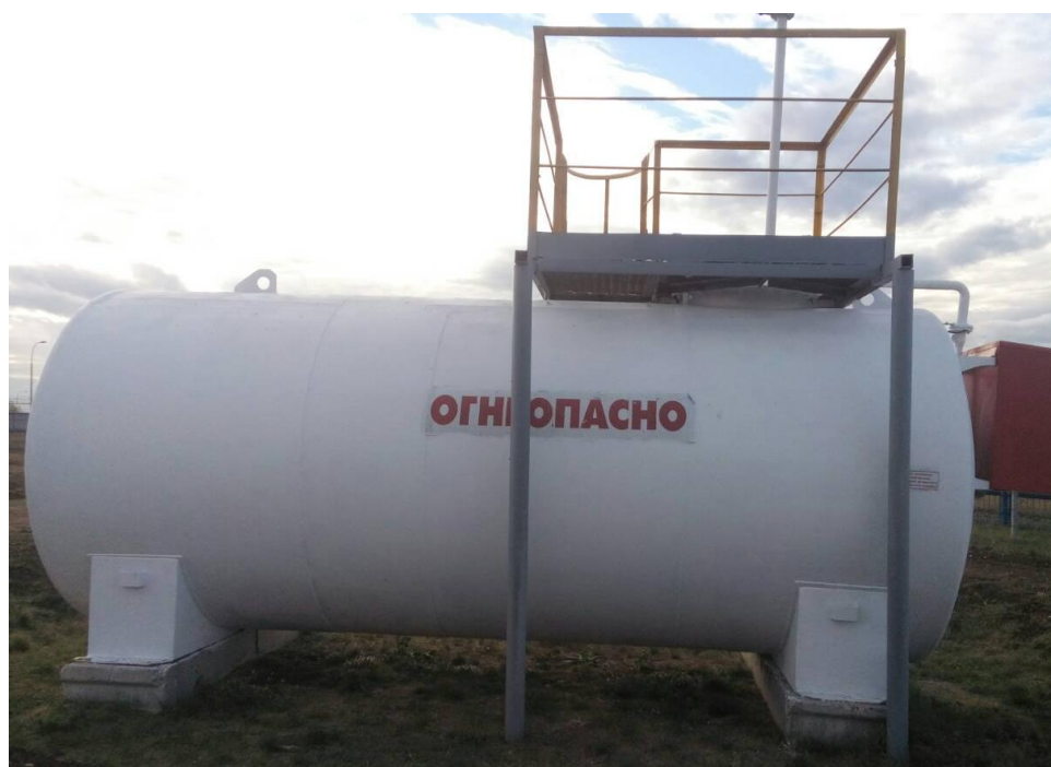
Рисунок 1 - Общий вид резервуара
