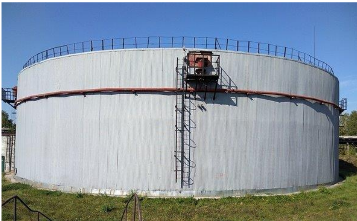
Рисунок 1 - Общий вид резервуара
