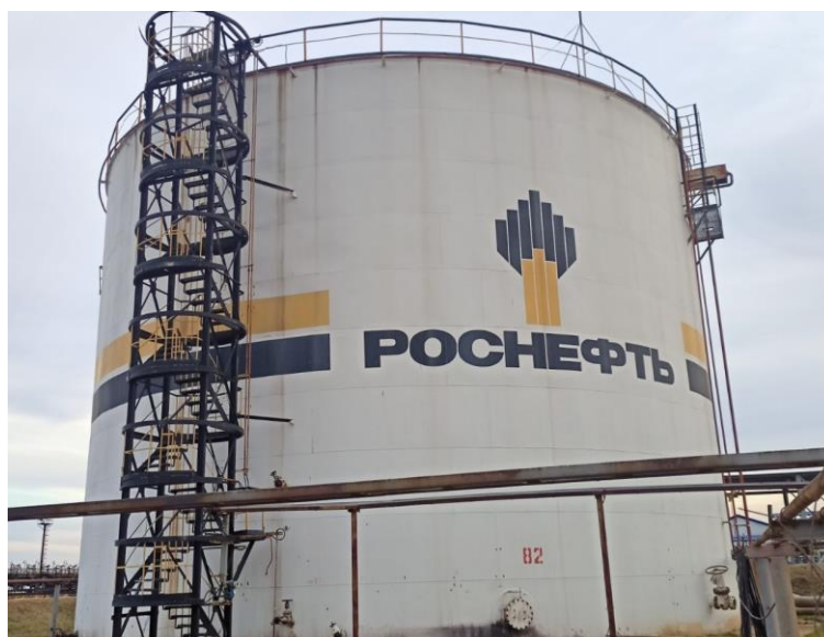
Рисунок 1 – Общий вид резервуаров стальных вертикальных цилиндрических РВС-5000
