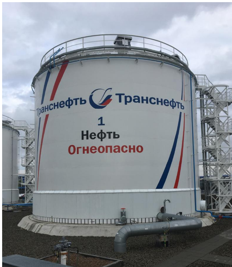
Рисунок 1 - Общий вид резервуаров вертикальных стальных цилиндрических РВС-2000
