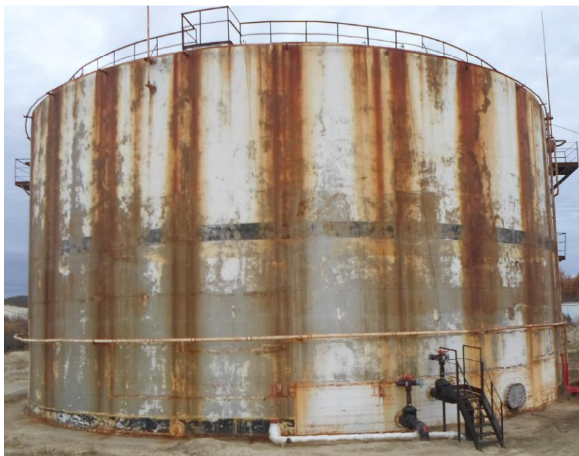
Рисунок 2 - Общий вид резервуара стального вертикального цилиндрического PVC-5000
