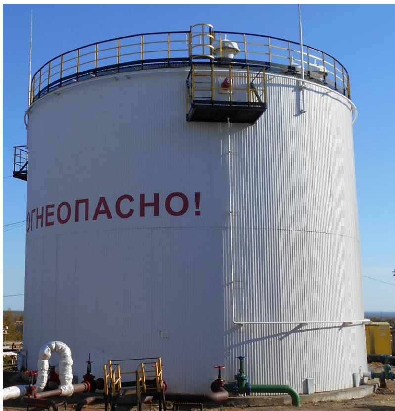
Рисунок 1 - Общий вид резервуара стального вертикального цилиндрического РВС-2000
