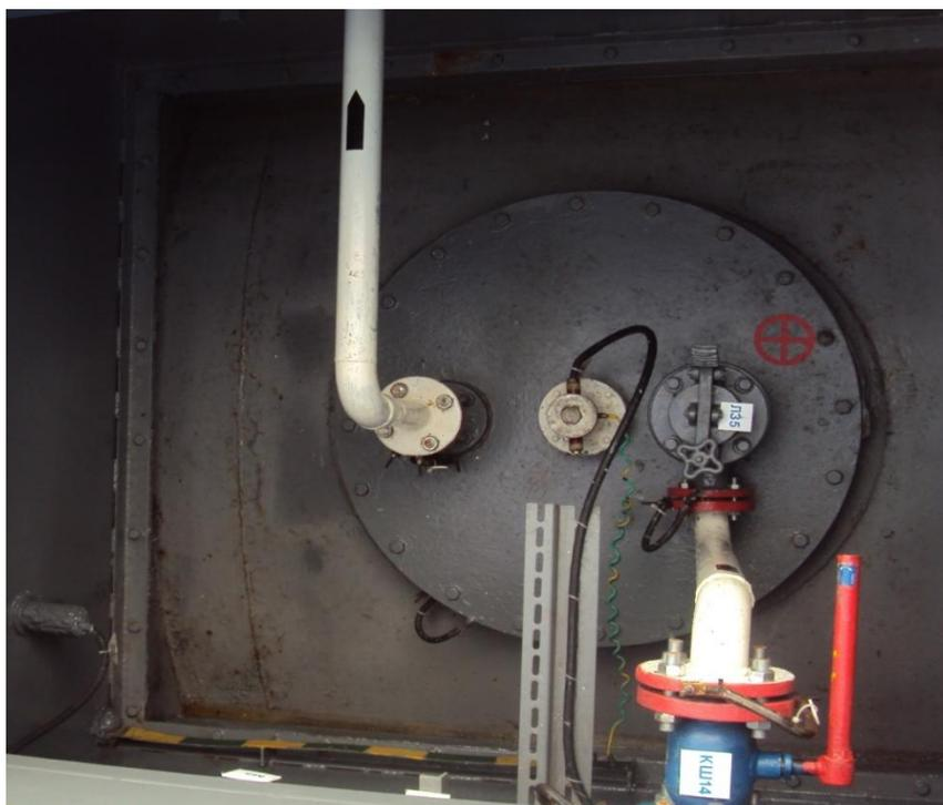
Рисунок 1 - Общий вид видимой части конструкции резервуара РГСО-25 № 0086.3
