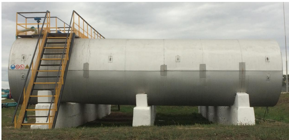
Рисунок 1 - Общий вид резервуара стального горизонтального цилиндрического РГС-60
