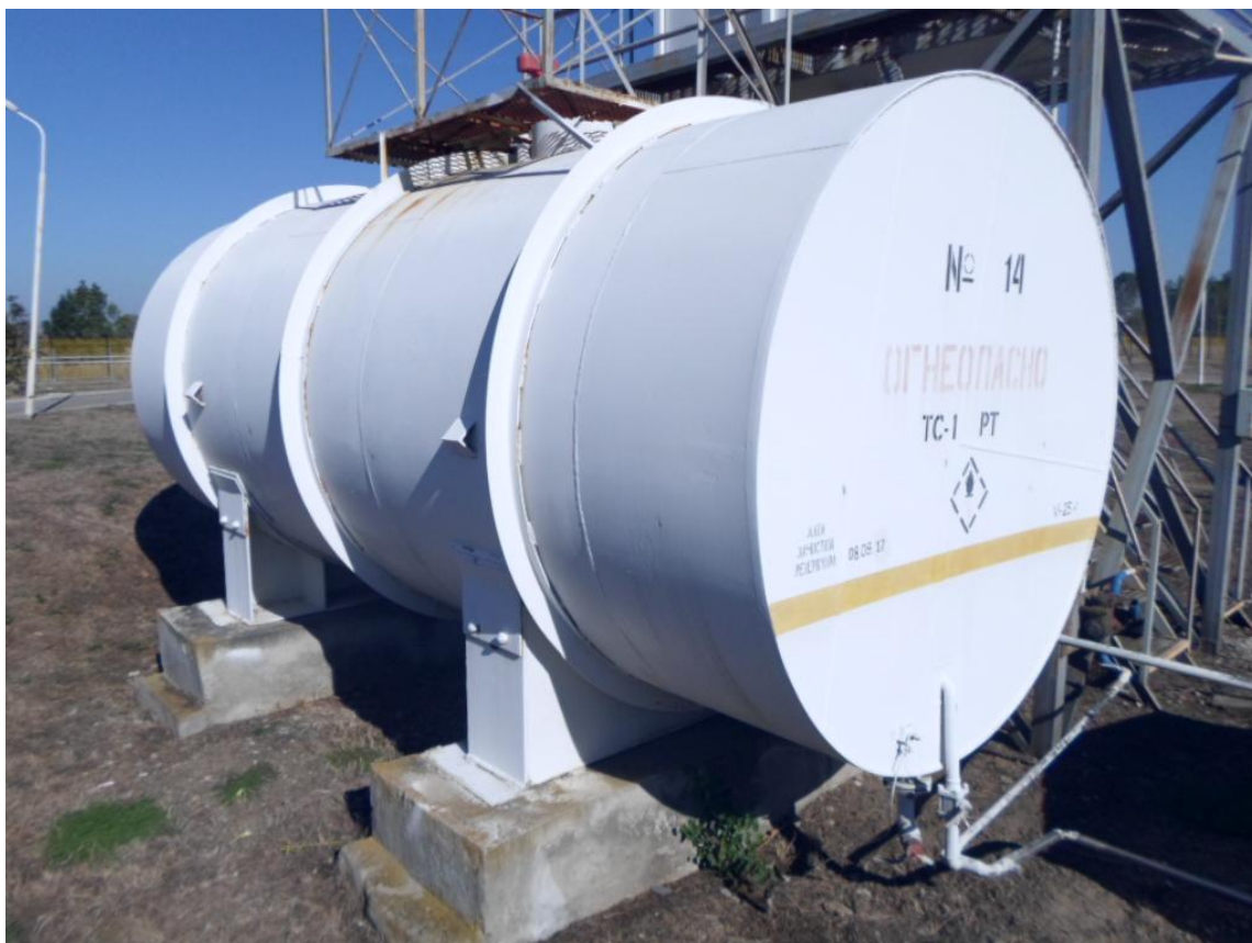
Рисунок 1 - Общий вид резервуара стального горизонтального цилиндрического РГС-25
