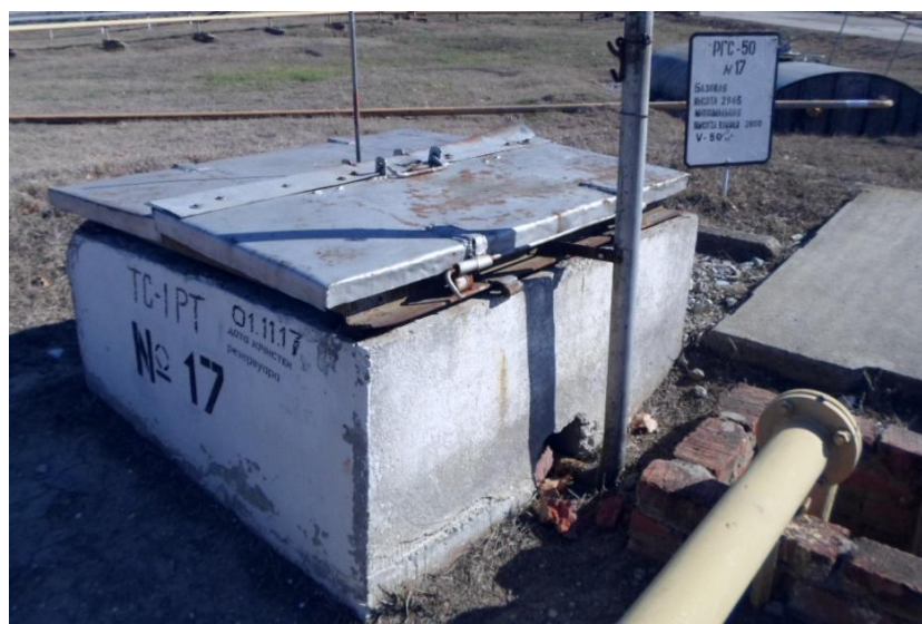
Рисунок 6 - Общий вид места установки (а) и эскиз (б) резервуара стального горизонтального цилиндрического РГС-25
