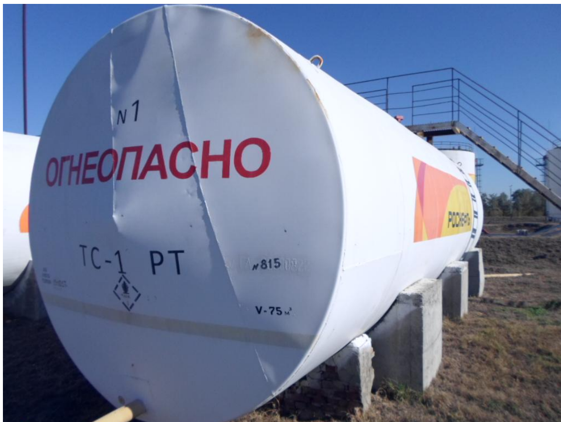
Рисунок 1 - Общий вид резервуара стального горизонтального цилиндрического РГС-75
