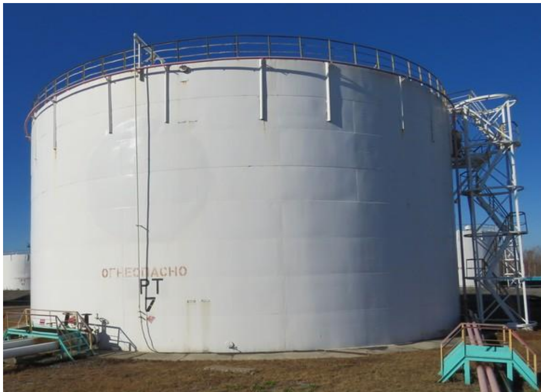
Рисунок 1 - Общий вид резервуара РВС-5000
