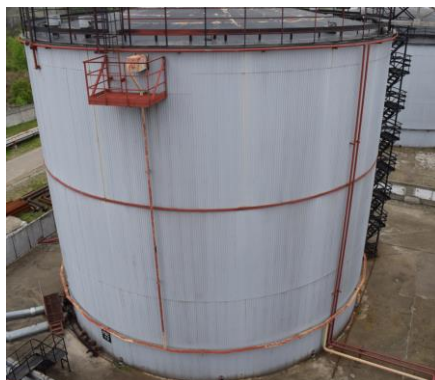
Рисунок 1 – Общий вид резервуаров
