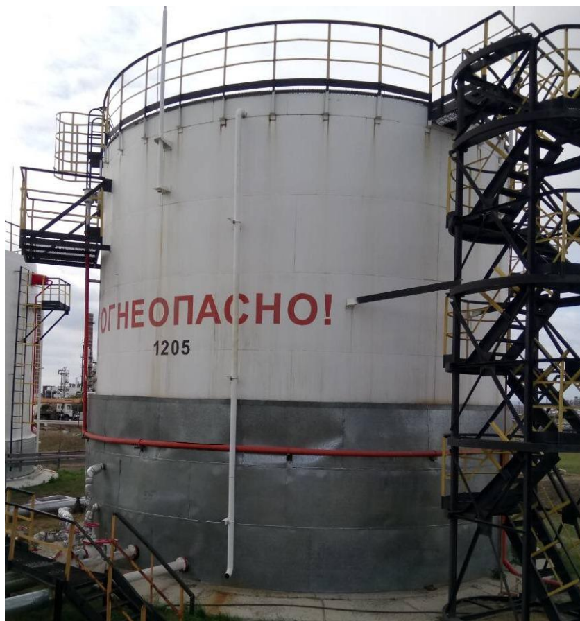
Рисунок 4 - Общий вид резервуара стального вертикального цилиндрического РВС-700
