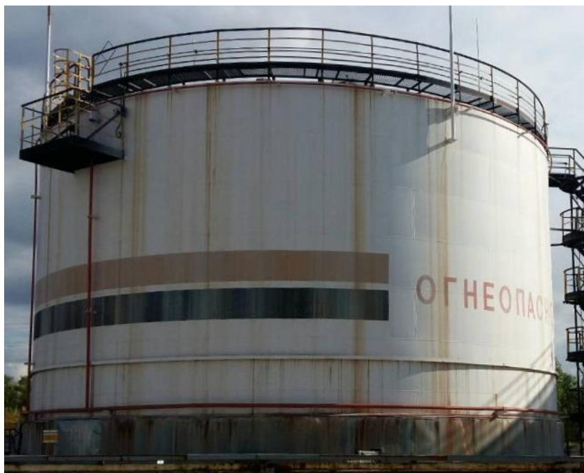
Рисунок 6 - Общий вид резервуара стального вертикального цилиндрического РВС-3000
