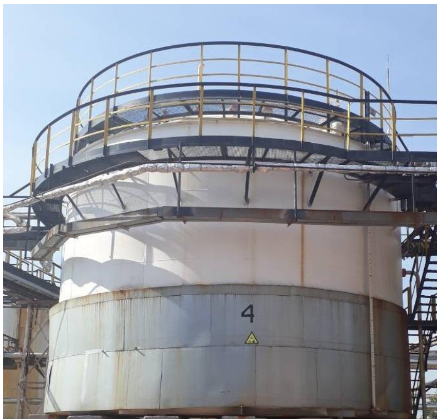
Рисунок 2 - Общий вид резервуара стального вертикального цилиндрического РВС-300
