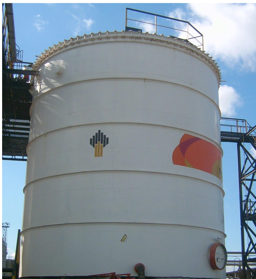
Рисунок 3 - Общий вид резервуара стального вертикального цилиндрического РВС-500
