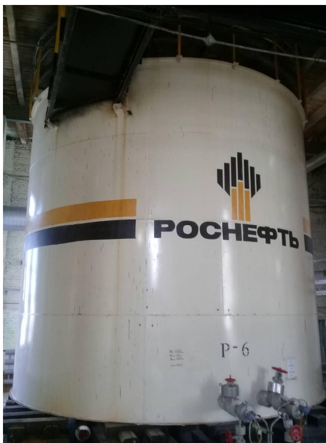
Рисунок 1 - Общий вид резервуара стального вертикального цилиндрического РВС-200
