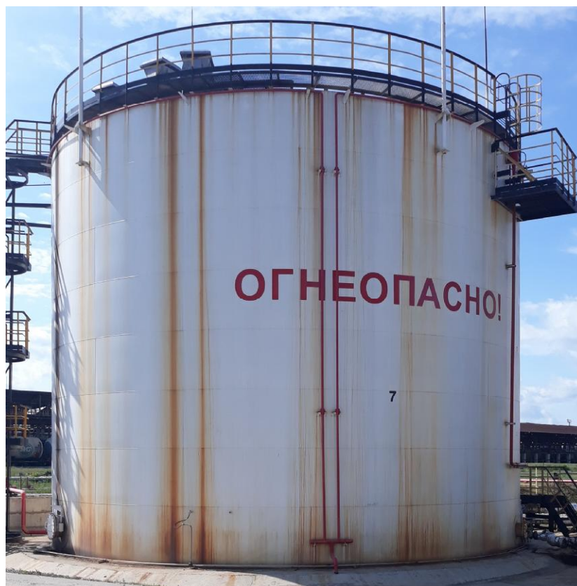
Рисунок 5 - Общий вид резервуара стального вертикального цилиндрического РВС-2000
