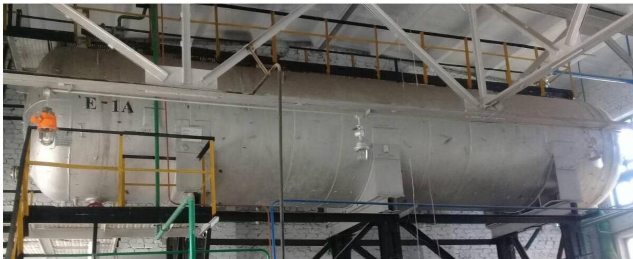
Рисунок 1 - Общий вид резервуара стального горизонтального цилиндрического РГС-50
