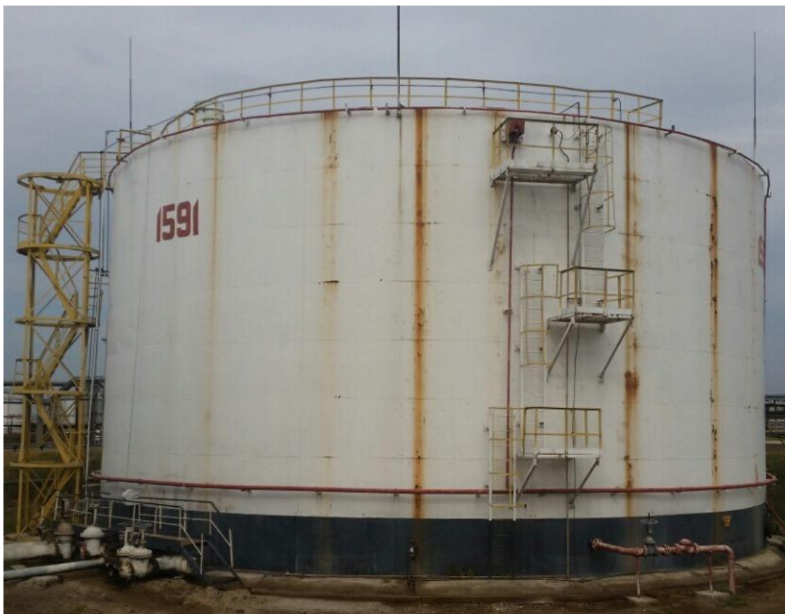
Рисунок 1 - Общий вид резервуара стального вертикального цилиндрического РВС-5000
