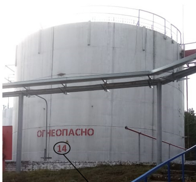
Рисунок 1 – Общий вид резервуара РВС-1000 №13 с указанием места нанесения заводского номера
