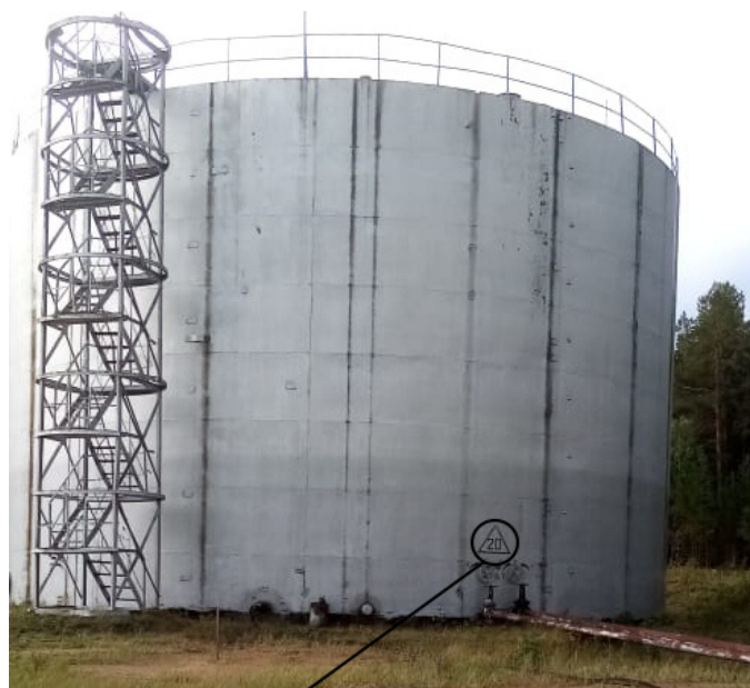
Рисунок 1 – Общий вид резервуара РВС-3000 №18 с указанием места нанесения заводского номера
