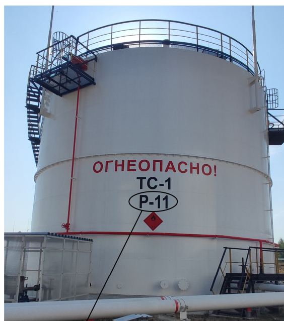
Рисунок 1 – Общий вид резервуара РВС-2000 №Р-8 с указанием места нанесения заводского номера
