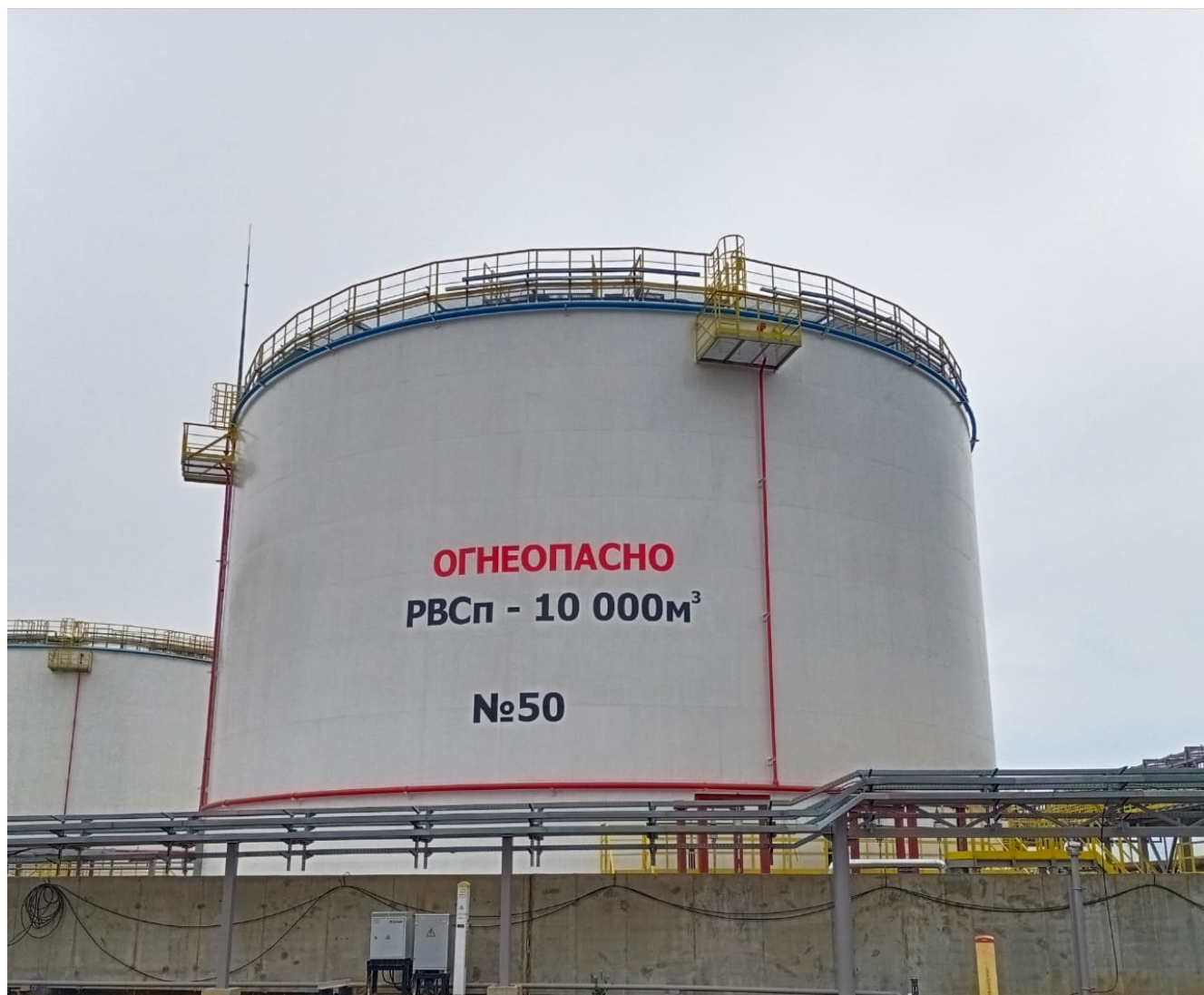
Рисунок 1 – Фотография общего вида резервуара вертикального стального цилиндрического с понтоном РВСП-10000 заводской номер 50.
