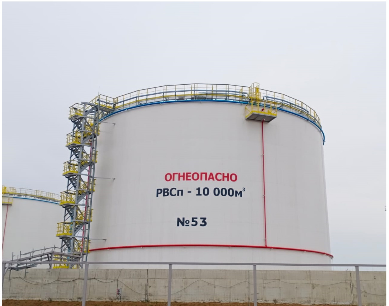
Рисунок 4 – Фотография общего вида резервуара вертикального стального цилиндрического с понтоном РВСП-10000 заводской номер 53.
