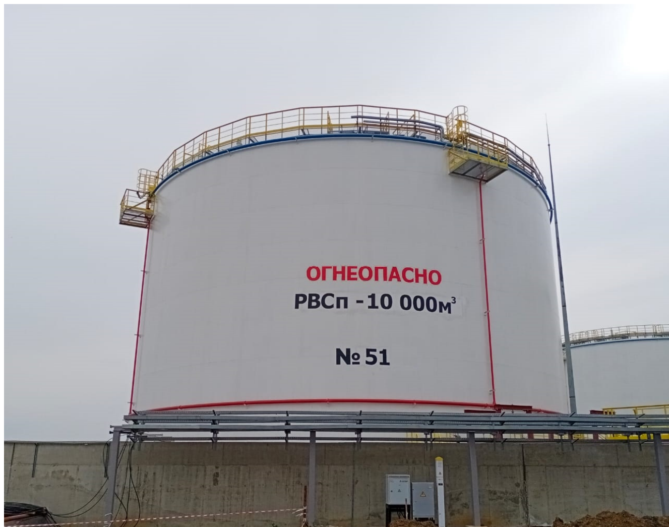
Рисунок 2 – Фотография общего вида резервуара вертикального стального цилиндрического с понтоном РВСП-10000 заводской номер 51.
