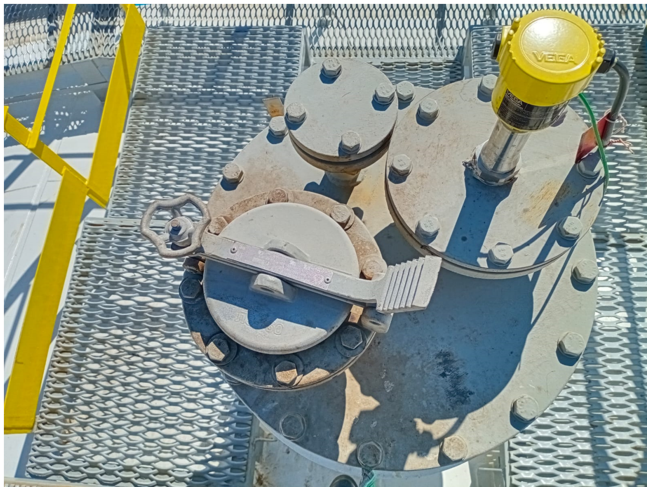
Рисунок 6 – Фотография крышки замерного люка резервуара вертикального стального цилиндрического с понтоном РВСП-10000 заводской номер 51.
