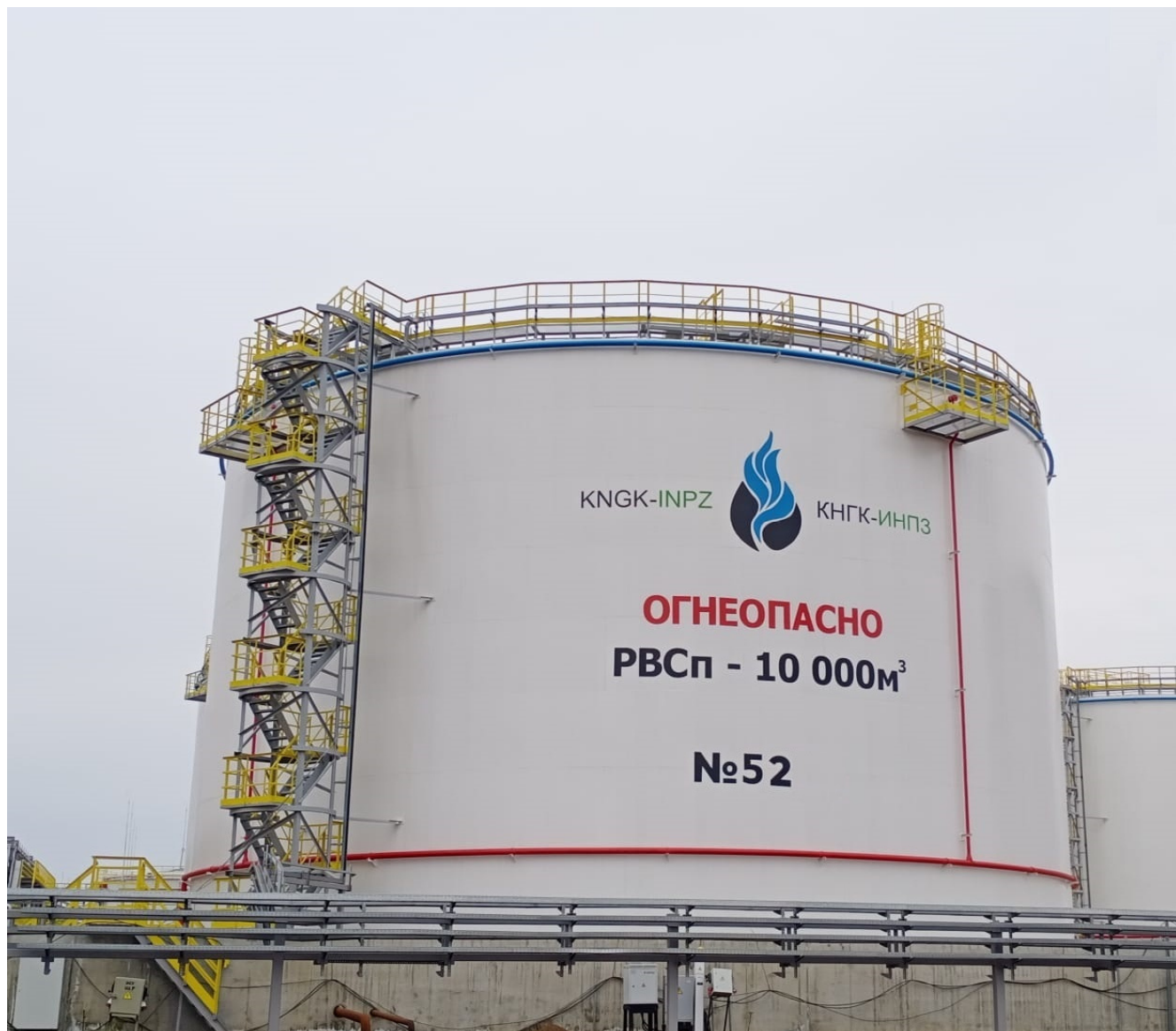
Рисунок 3 – Фотография общего вида резервуара вертикального стального цилиндрического с понтоном РВСП-10000 заводской номер 52.
