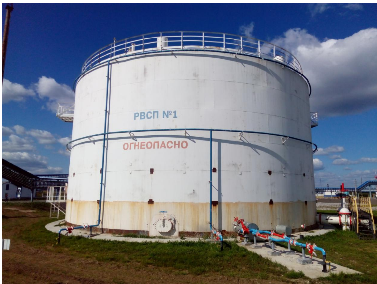
Рисунок 1 - Общий вид резервуаров вертикальных стальных цилиндрических РВСП-5000
