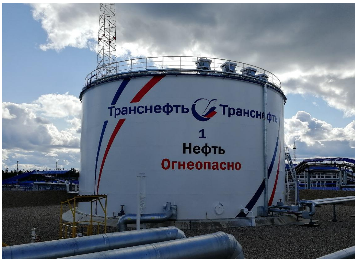
Рисунок 1 - Общий вид резервуаров вертикальных стальных цилиндрических РВС-5000
