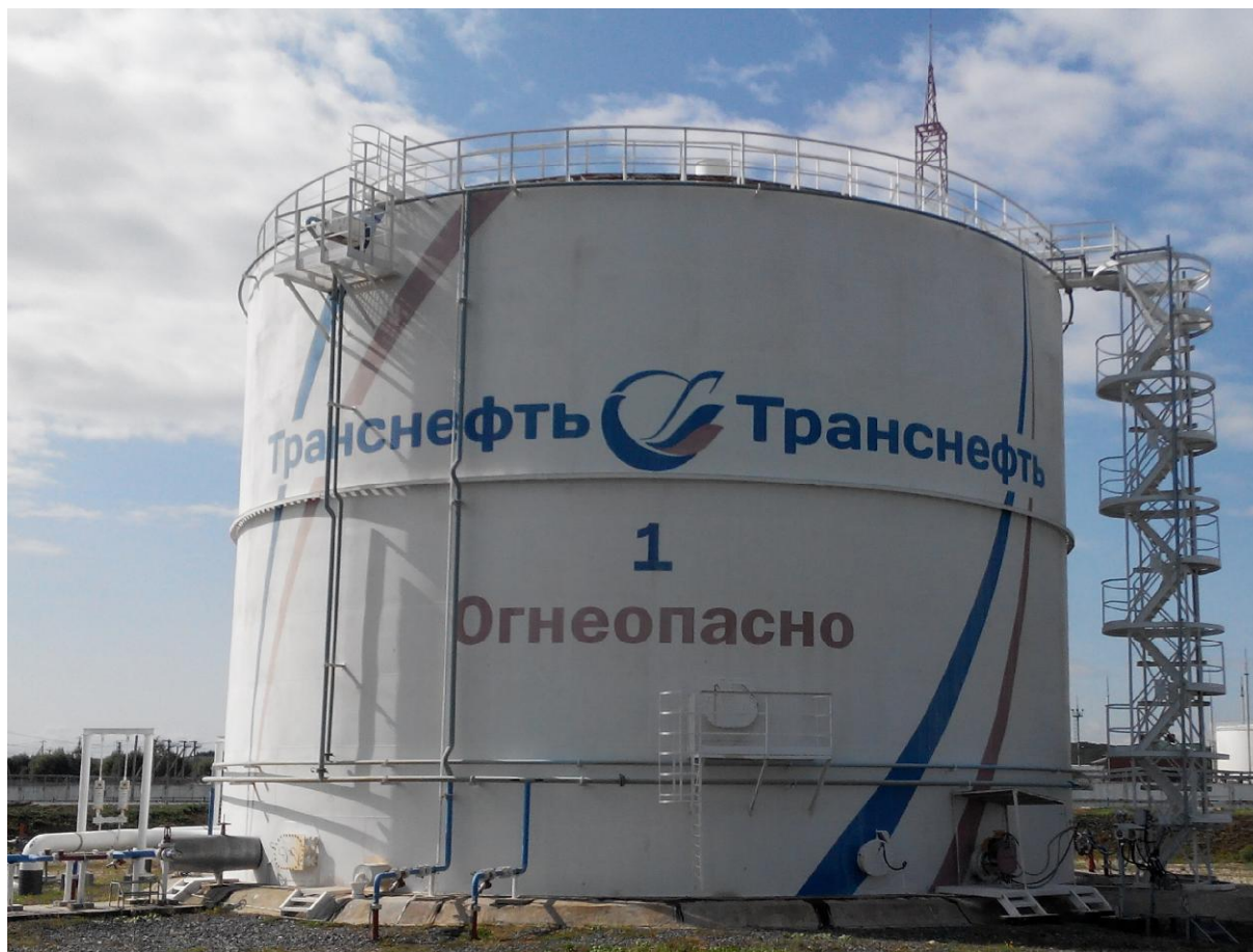
Рисунок 1 - Общий вид резервуаров вертикальных стальных цилиндрических РВСП-5000
