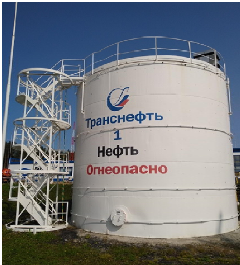
Рисунок 1 - Общий вид резервуаров вертикальных стальных цилиндрических РВС-400
