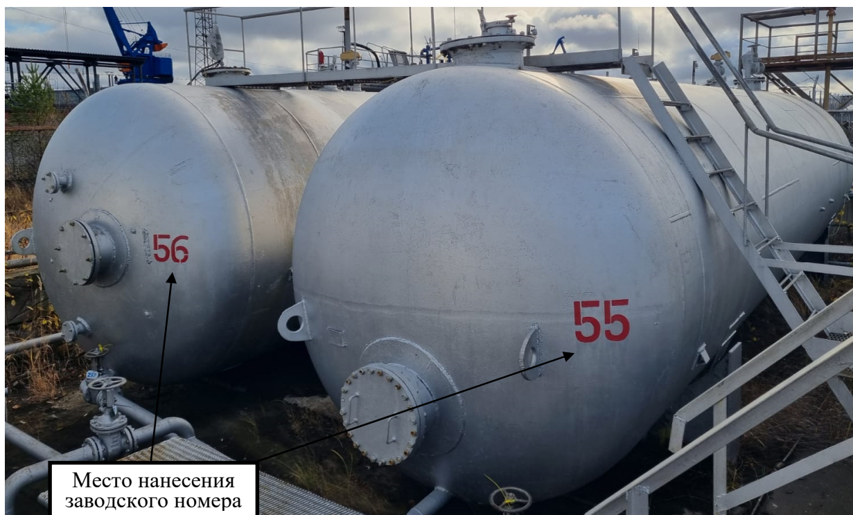
Рисунок 1 – Общий вид резервуаров
