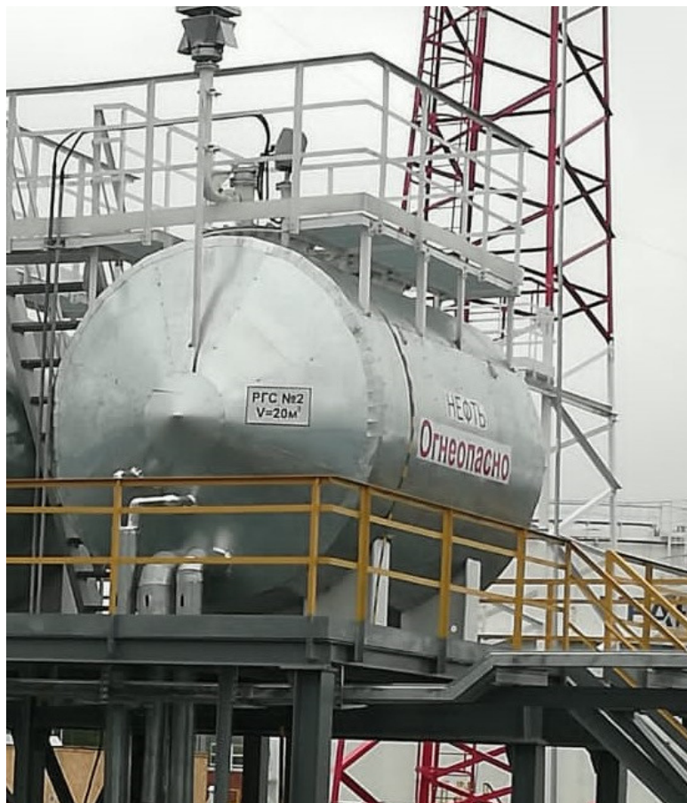
Рисунок 2 – Общий вид резервуара РГС-20 зав.№ 7258
