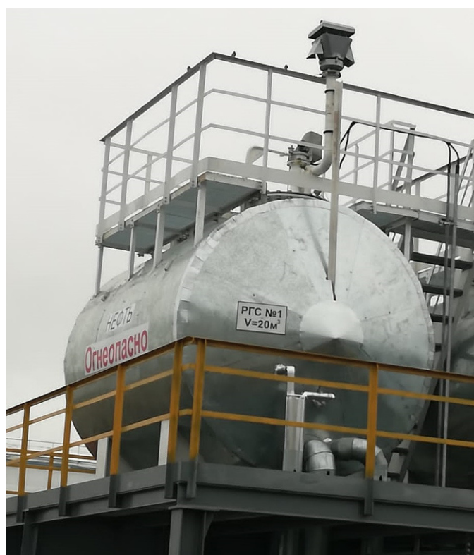
Рисунок 3 – Общий вид резервуара РГС-20 зав.№ 7259
