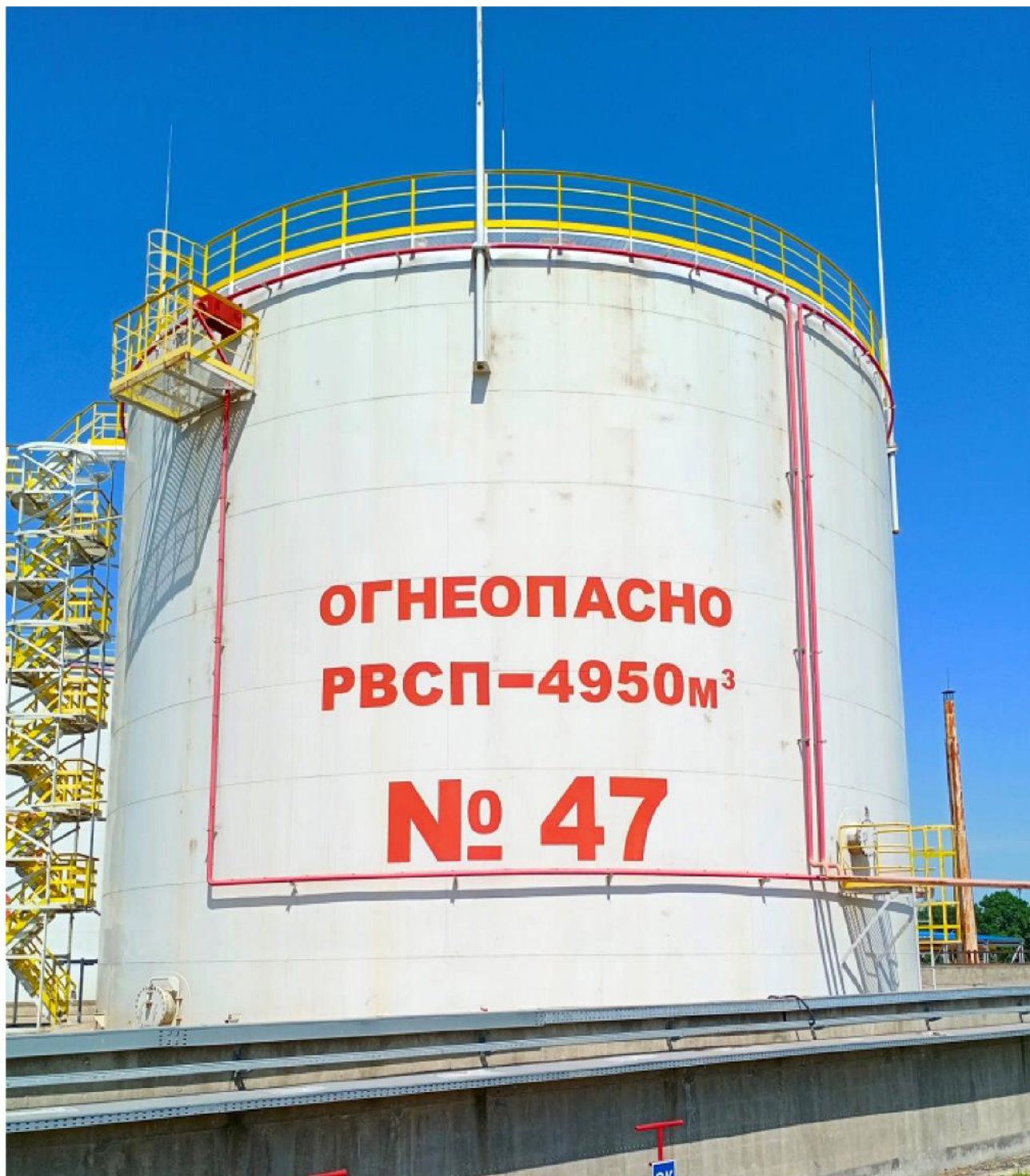
Рисунок 1 - Фотография общего вида резервуара РВСП-4950 заводской номер 47
