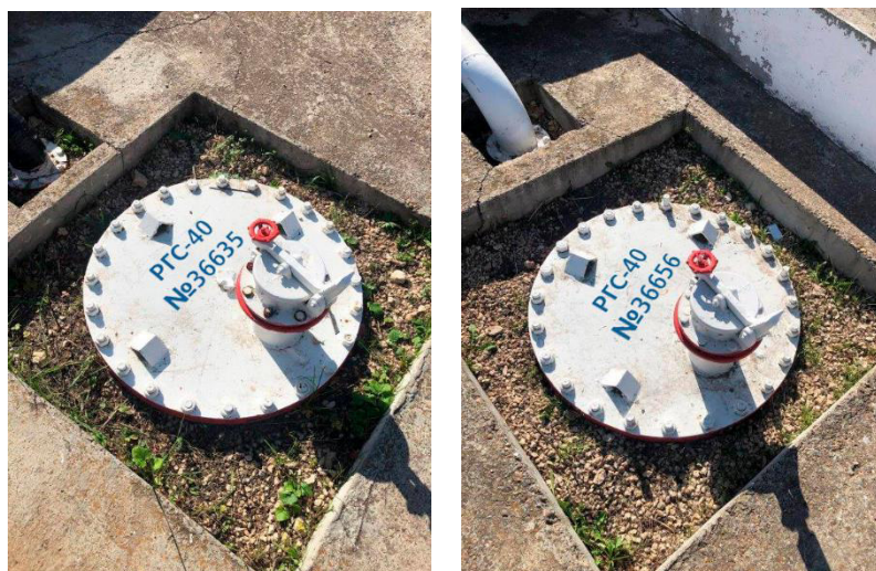
Рисунок 1 – Общий вид крышек резервуаров РГС-40
