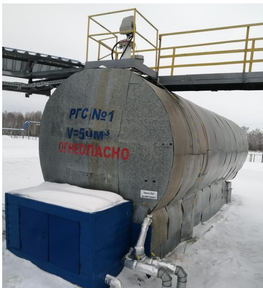
Рисунок 2 – Общий вид резервуара РГС-50
