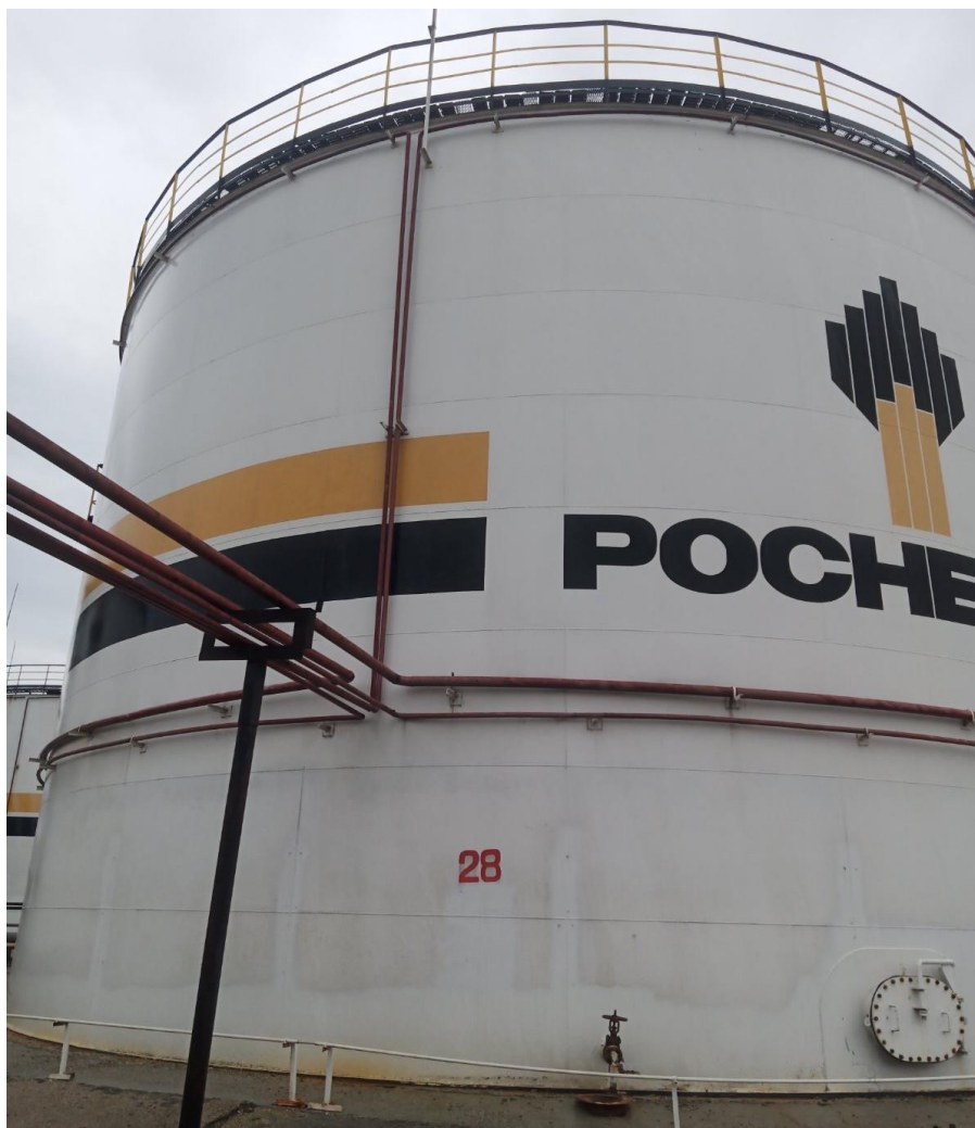
Рисунок 1 – Общий вид резервуара РВСП-3000 №28
