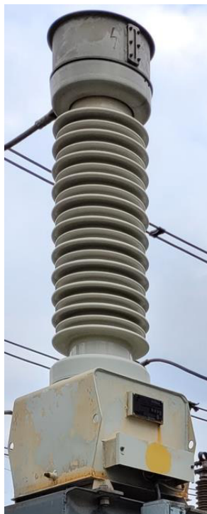
Рисунок 1 - Общий вид трансформаторов напряжения с указанием места нанесения знака утверждения типа, места нанесения заводского номера
