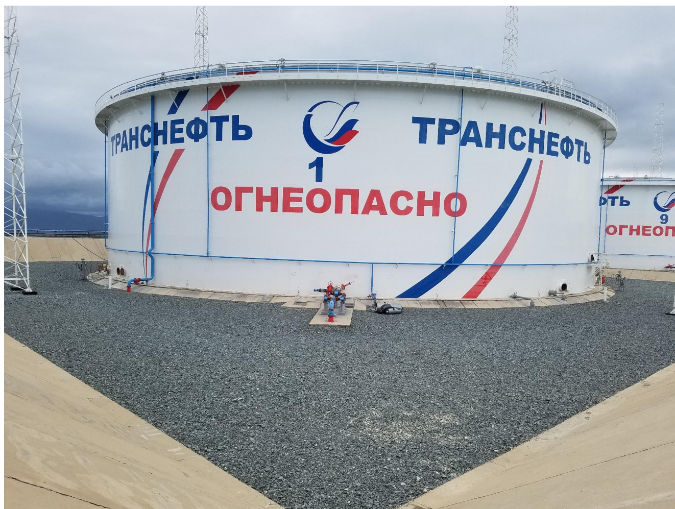
Рисунок 2 - Общий вид резервуара вертикального стального цилиндрического РВСПК-50000
