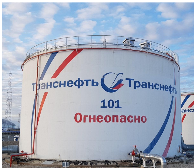
Рисунок 1 - Общий вид резервуара вертикального стального цилиндрического РВС-5000
