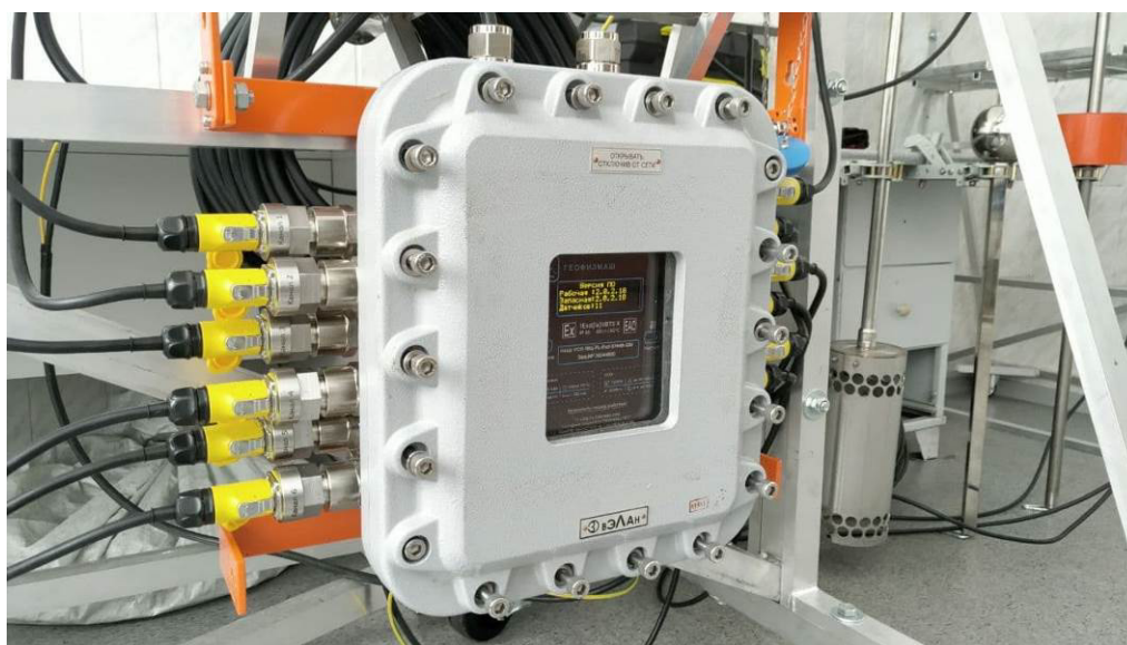
Рисунок 8 – общий вид среднего уровня (взрывозащищённые контроллеры серии Кедр УСО)
