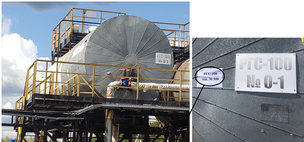
Рисунок 1 – Общий вид резервуара РГС-100 №507 с указанием места нанесения заводского номера
