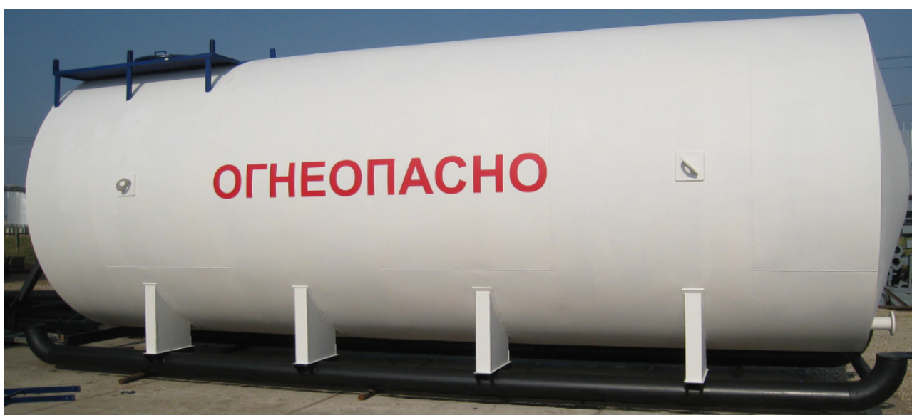
Рисунок 2 – Общий вид резервуаров
