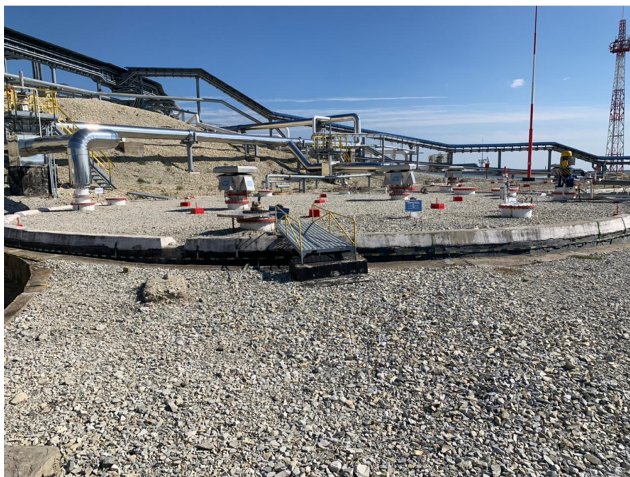
Рисунок 1 – Общий вид резервуаров
