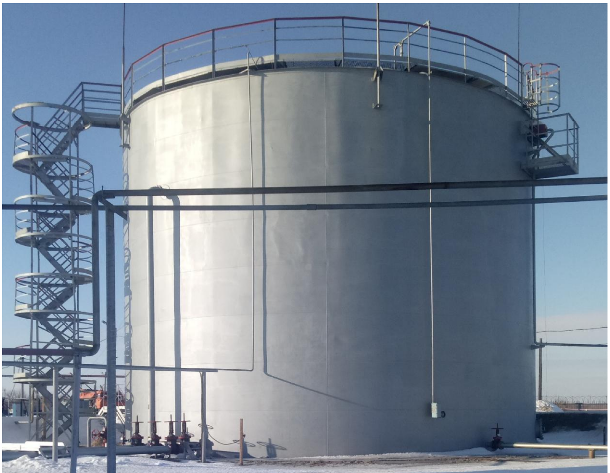
Рисунок 1 - Резервуар вертикальный стальной РВС-2000
