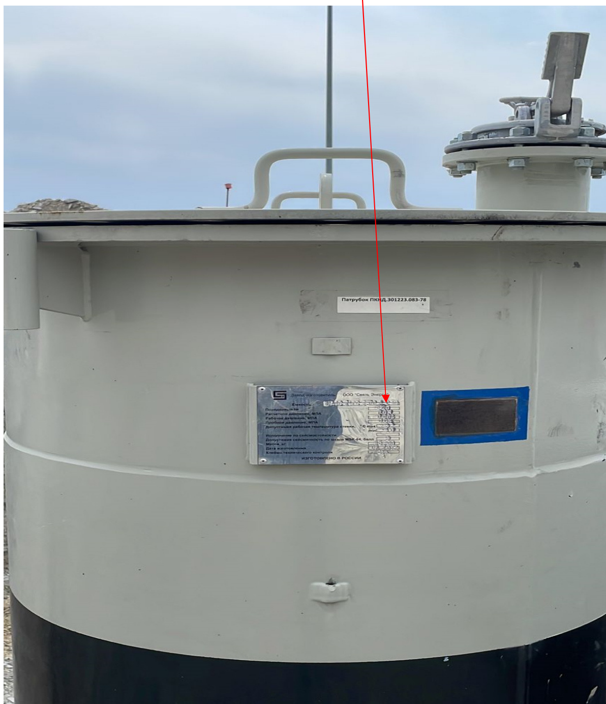
Рисунок 2 - Фотография горловины резервуара ЕП-40 заводской номер 320, с указанием места нанесения наименования, обозначения и заводского номера
