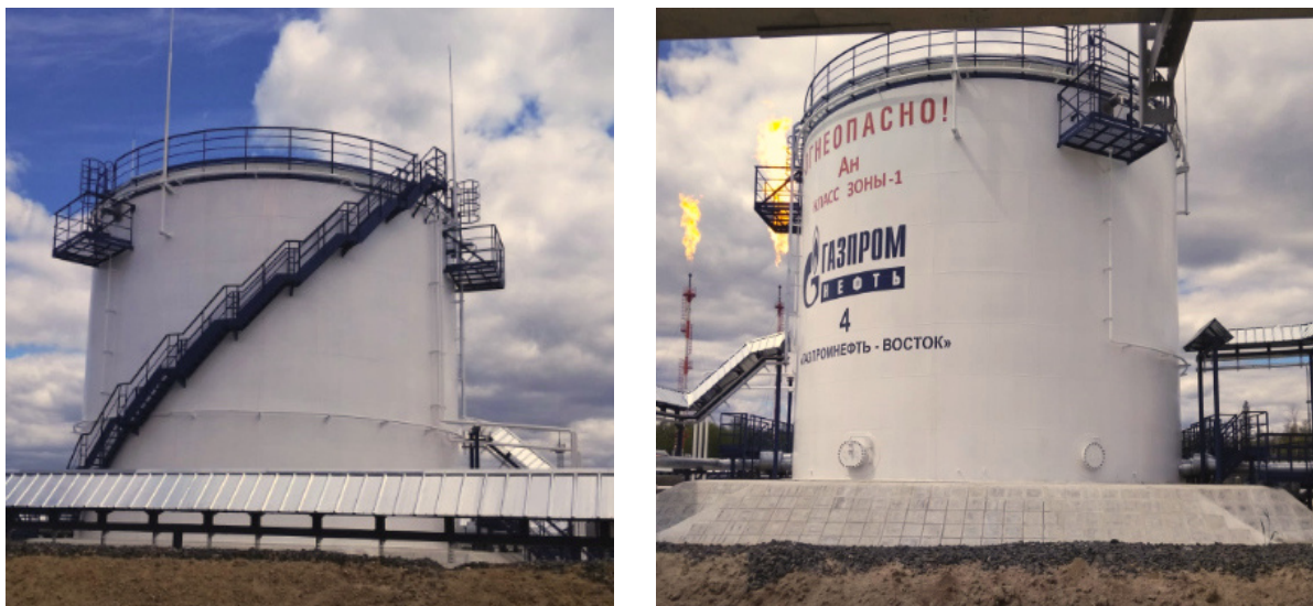
Рисунок 1 – Общий вид резервуара стального вертикального цилиндрического РВС-2000
