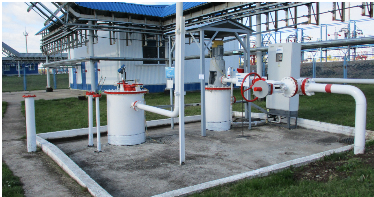
Рисунок 3 – Горловины и измерительный люк резервуара
