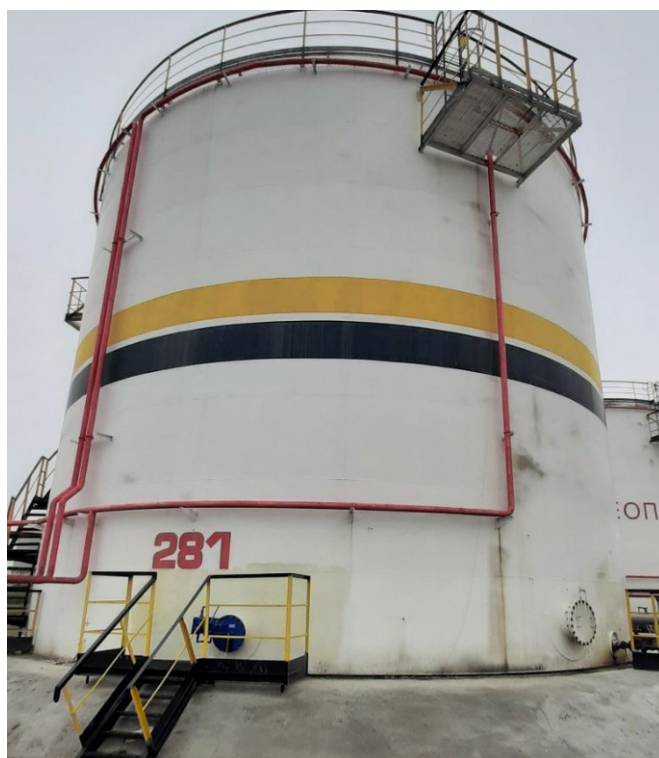
Рисунок 4 – Общий вид резервуара РВСП-2000 №281
