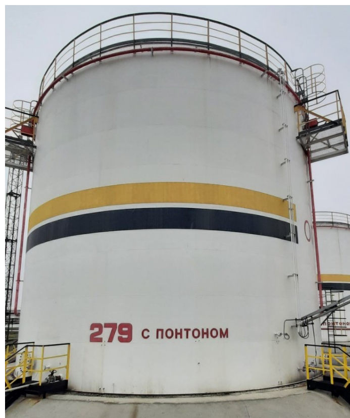
Рисунок 2 – Общий вид резервуара РВСП-2000 №279
