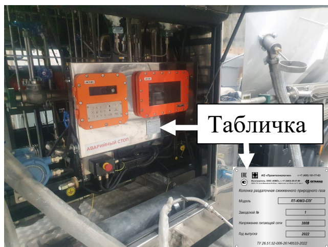
Рисунок 2 – Место установки маркировочной таблички
