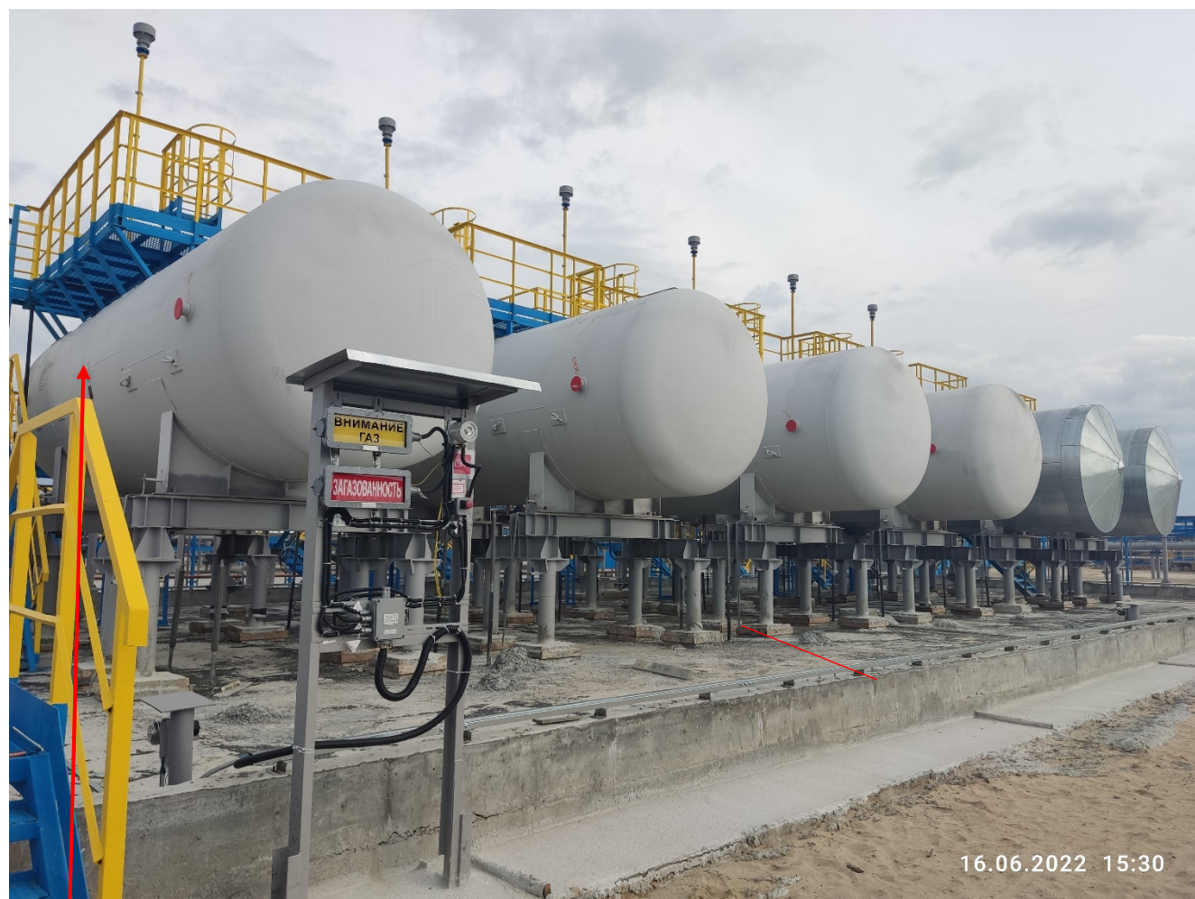
Рисунок 1 - Общий вид резервуаров горизонтальных стальных цилиндрических SU-42 с заводскими номерами 170/190137, 171/190137, 172/190137, 173/190137, 174/190138, 175/190138 с указанием места нанесения заводского номера
